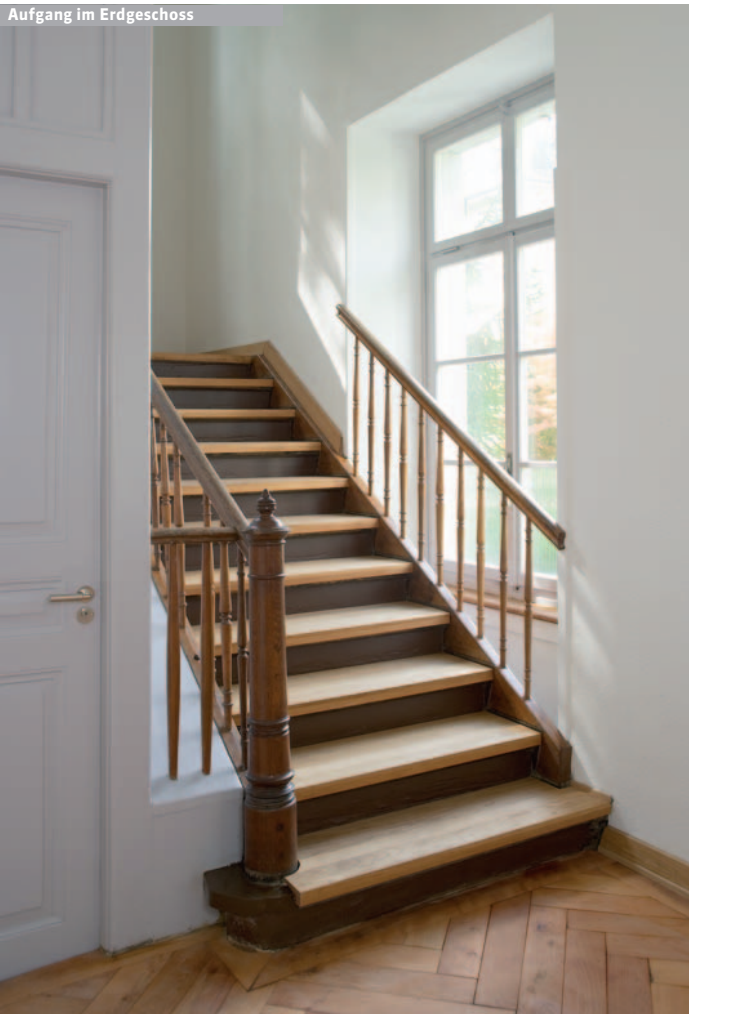
Aufgang im Erdgeschoss
